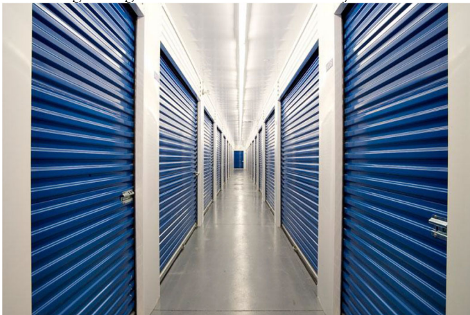
Abbildung 2: Lagereinheiten mit Trennwandsystemen
