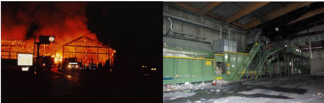
Abbildung 2: linkes Bild: Brand eines Abfallverwertungsbetriebes im Jahr 2004 – Totalschaden; rechtes Bild: ähnlich gelagerte Brandentstehung im selben Betrieb im Jahr 2014 – durch optimierte, objekt- und nutzungsbezogene Brandschutzmaßnahmen nach dem ersten Brand konnte das Schadensausmaß beim zweiten Brand drastisch reduziert werden. (Quelle: Brandverhütungsstelle Niederösterreich mit freundlicher Genehmigung des Betreibers)
